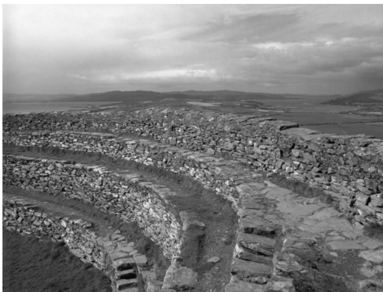
Fig. 10. La struttura terrazzata del muro di fortificazione del Grianan Aileach.
