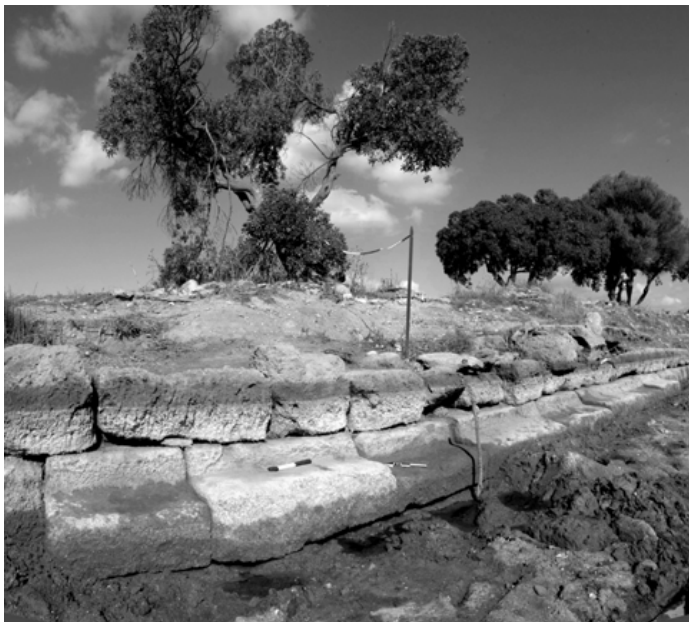
Fig. 4. L'apprestamento a blocchi attraverso il quale l'acqua dolce dalla falda freatica sgorga nella piscina del Kothon.
