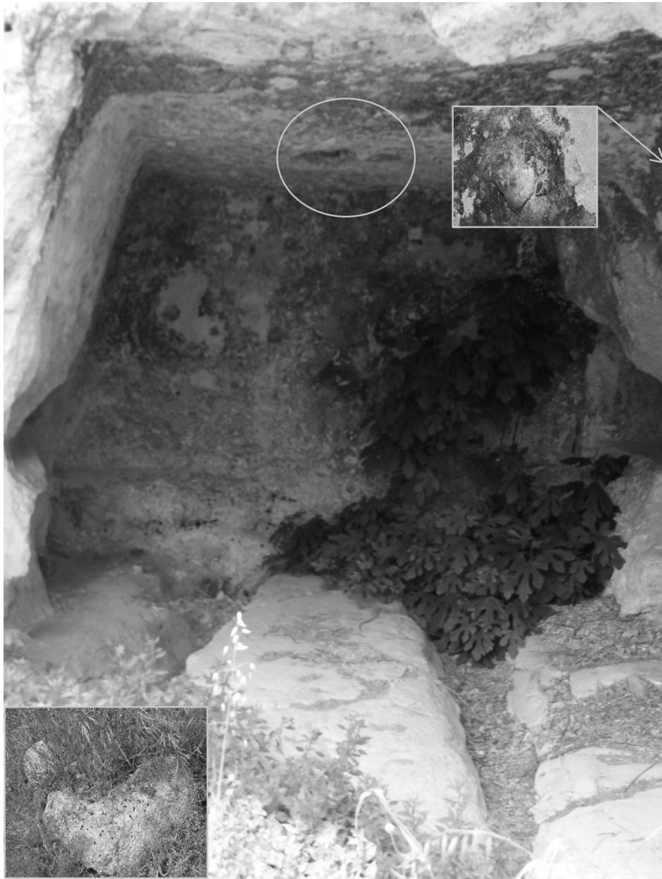
Fig. 4. Grotta con pozzo esterno, base rocciosa tra due canali di scolo, aggancio scavato nella volta e scultura in rilievo.
