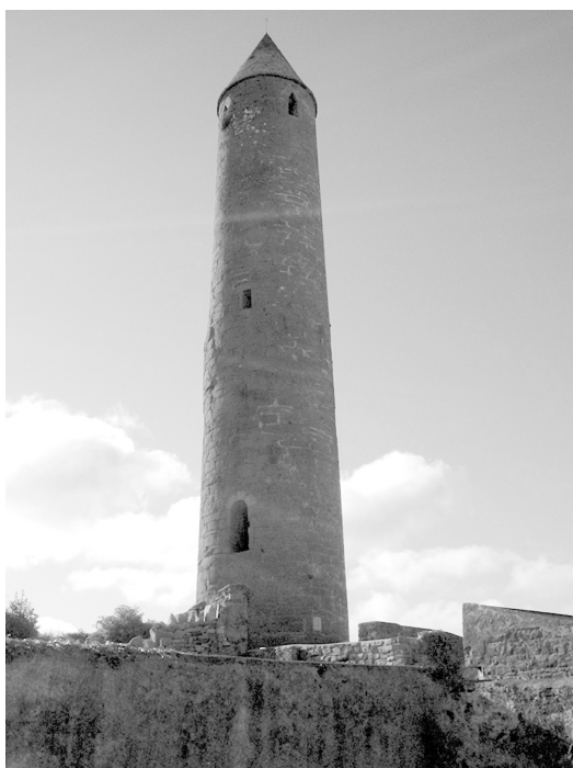
Fig. 4. La cloigheach di Killala (Co. Mayo) con la porta d'accesso posta a considerevole altezza rispetto al suolo. Le due monofore sommitali sono allineate verso nord (quella di destra) e verso sud (quella di sinistra).
